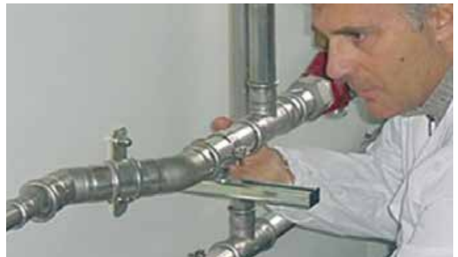
Fig. 33 - Kontrol af pressamling
