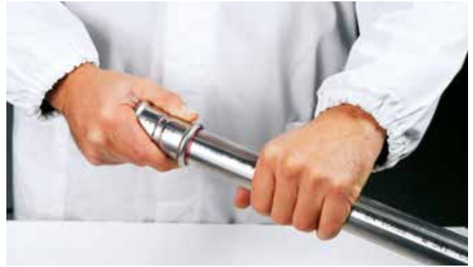
Fig. 31 - Indføring af rør i presfitting
