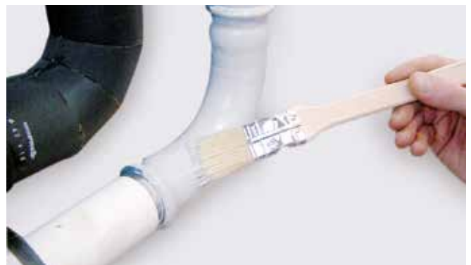
Fig. 34 - Lakering af rør og tilslutninger med grunder.
