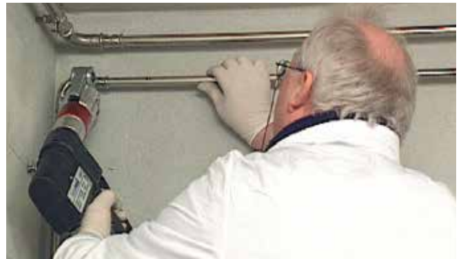
Fig. 32 - Udførelse af presssamling
